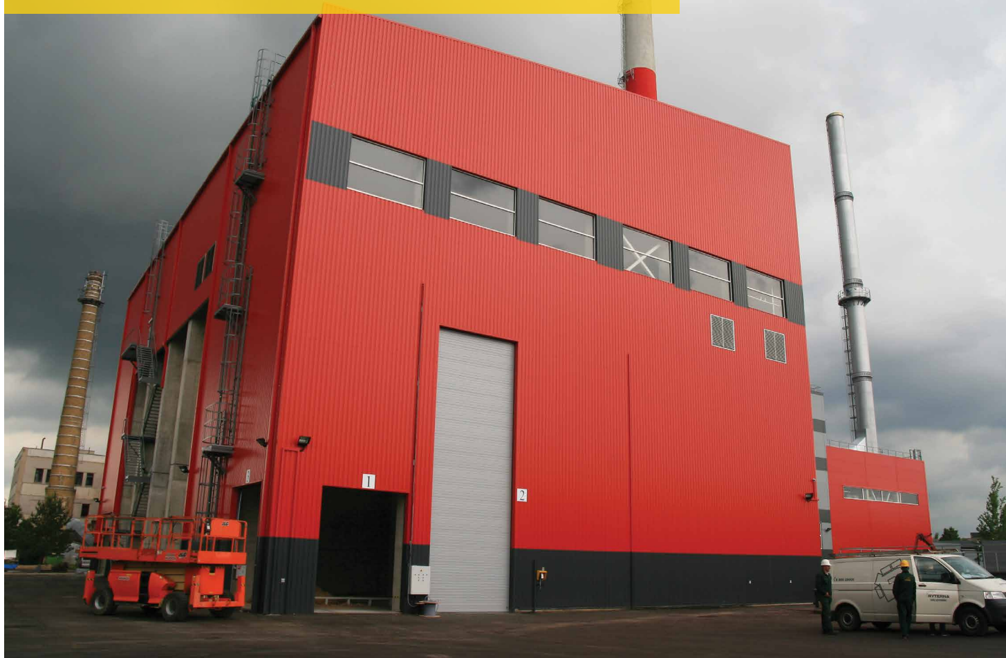
PORTES DE CENTRALE ÉLECTRIQUE - 4,5 MÈTRES DE LARGE ET 11 MÈTRES DE HAUT
