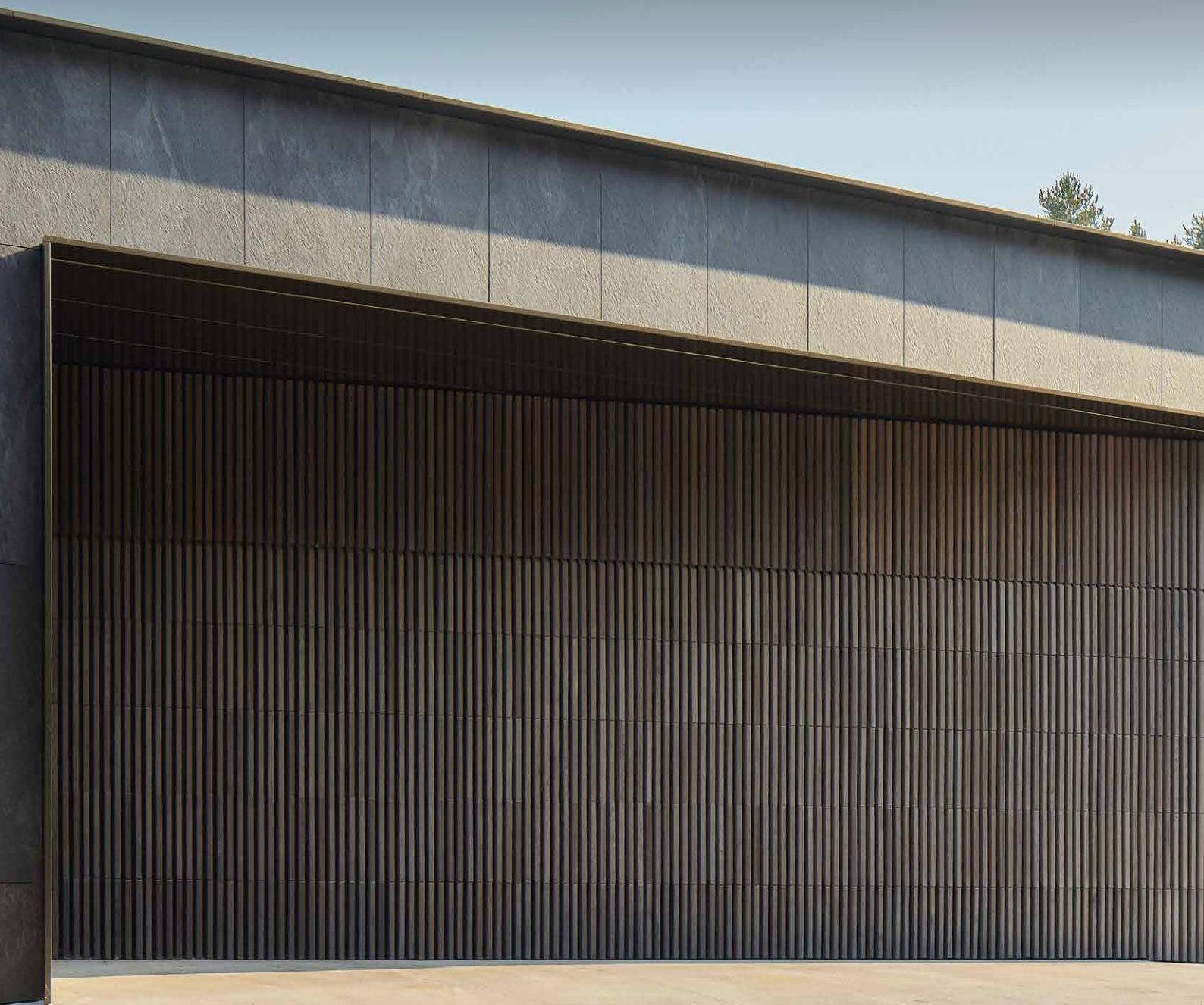
GARAGEDEUR EN GEVELPANEEL BEKLEED MET LARIKS LATTEN
